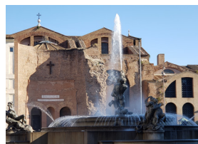
Fachada da Basilica. .
