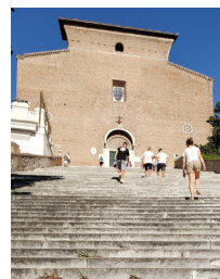
Escada e fachada.
